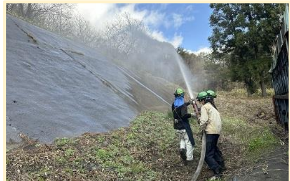
～裏山へ放水～ 強風の日は火事予防の放水が必須。 2024年4月19日
